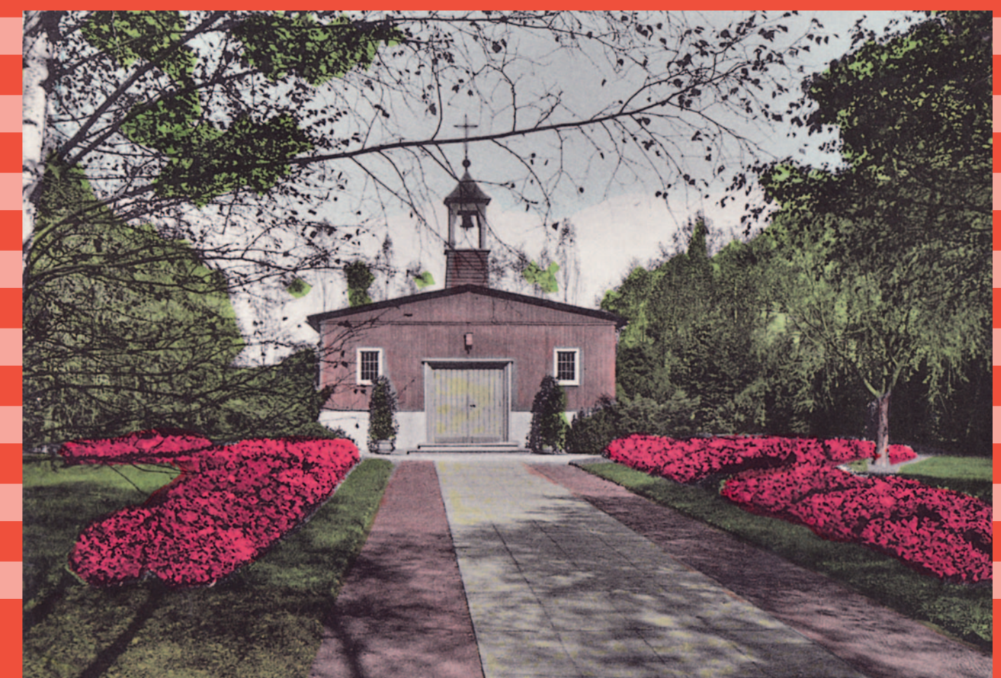
Die Katholische Lagerkirche, 1962. Im Wohnblock der Caritas stand in einer parkähnlichen Anlage die Katholische Lagerkirche, die heute jedoch nicht mehr existiert. Sie war, wie auch die 1949 eingeweihte und heute unter Denkmalschutz stehende Evangelische Lagerkirche, aus einer Baracke entstanden und trug einen kleinen, hölzernen Kirchturm. Es besuchten oft so viele Menschen die Gottesdienste, dass die beiden Kirchen dem Ansturm kaum gewachsen waren. © Archiv Gerd Plückelmann / Foto: Parkarte
